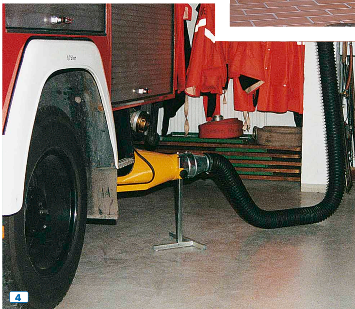
Abb. 3 Fahrzeughalle mit drei EXA-Saug Schlitzkanälen und schallgedämmtem Ventilator.
