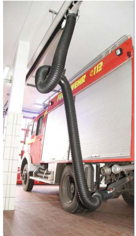
Der Absaugschlauch wird am Auspuff festgeklemmt – fährt das Fahrzeug los, läuft der Schlauch an der Deckenschiene bis zum Tor mit und koppelt sich dann automatisch ab. SPRINGER
