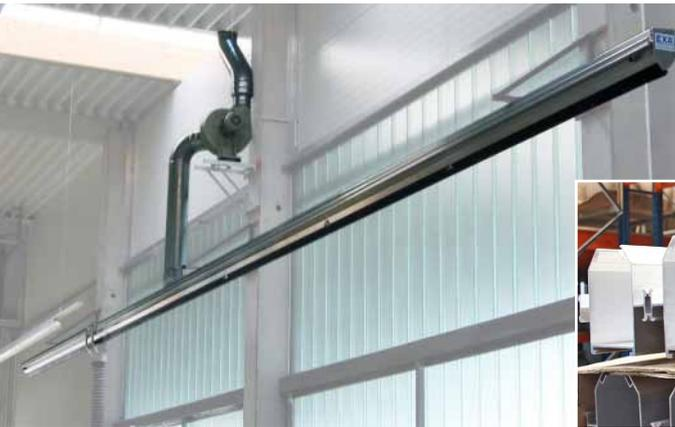
Eine Saugschlitzanlage deckt mehrere Werkstattplätze ab. Für solche Systeme bietet EXA verschiedene Saugschlitzkanal-Typen (unten). An ihnen kann dann der entsprechende Schlauchwagen verschoben werden.
