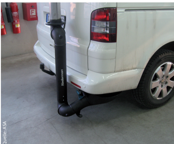
Bild links: Berührungslose Absaugeinrichtung für alle Fahrzeugtypen
